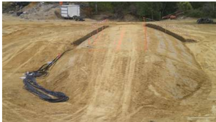
Digue en sol traité à la chaux
